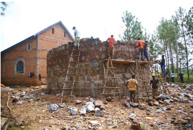
Bau einer Zisterne
